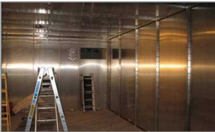
Assembling the Faraday cage / Montaż klatki Faradaya
