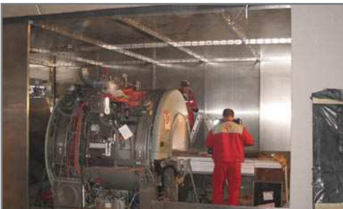
Assembling the scanner / Montaż skanera MRI
