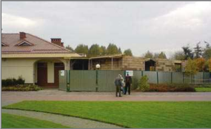
Building the Center's new wing / Dobudowa skrzydła budynku dla nowego Centrum
